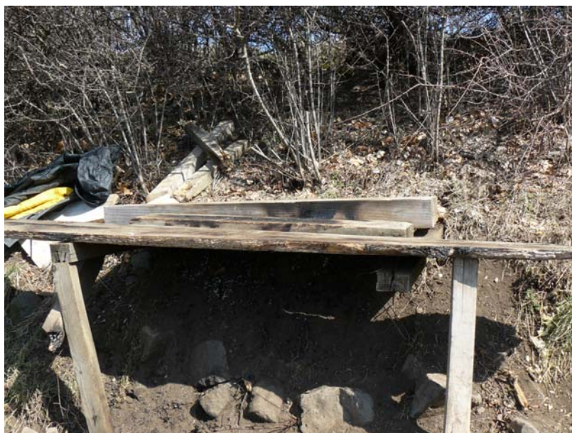
Figure 4 : Bancs vandalisés au col de l'Escrinet
