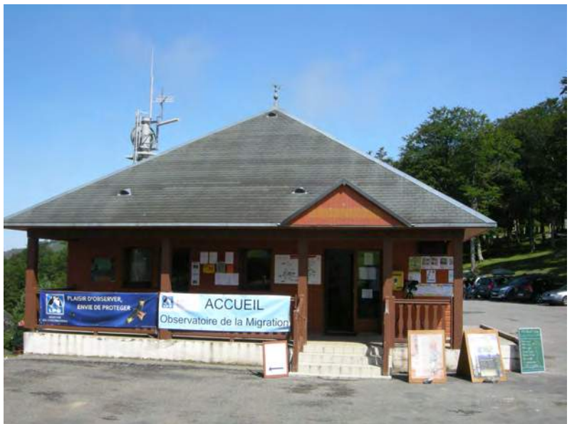
L'ancien Chalet d'accueil de la CSPS, recyclé en 2013 en accueil migration. Photo : G. Lignier
