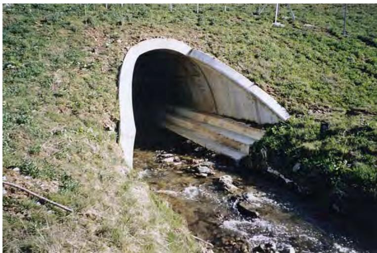
Figure 6 : Passage à Loutre sous l'A89 (© ASF).
