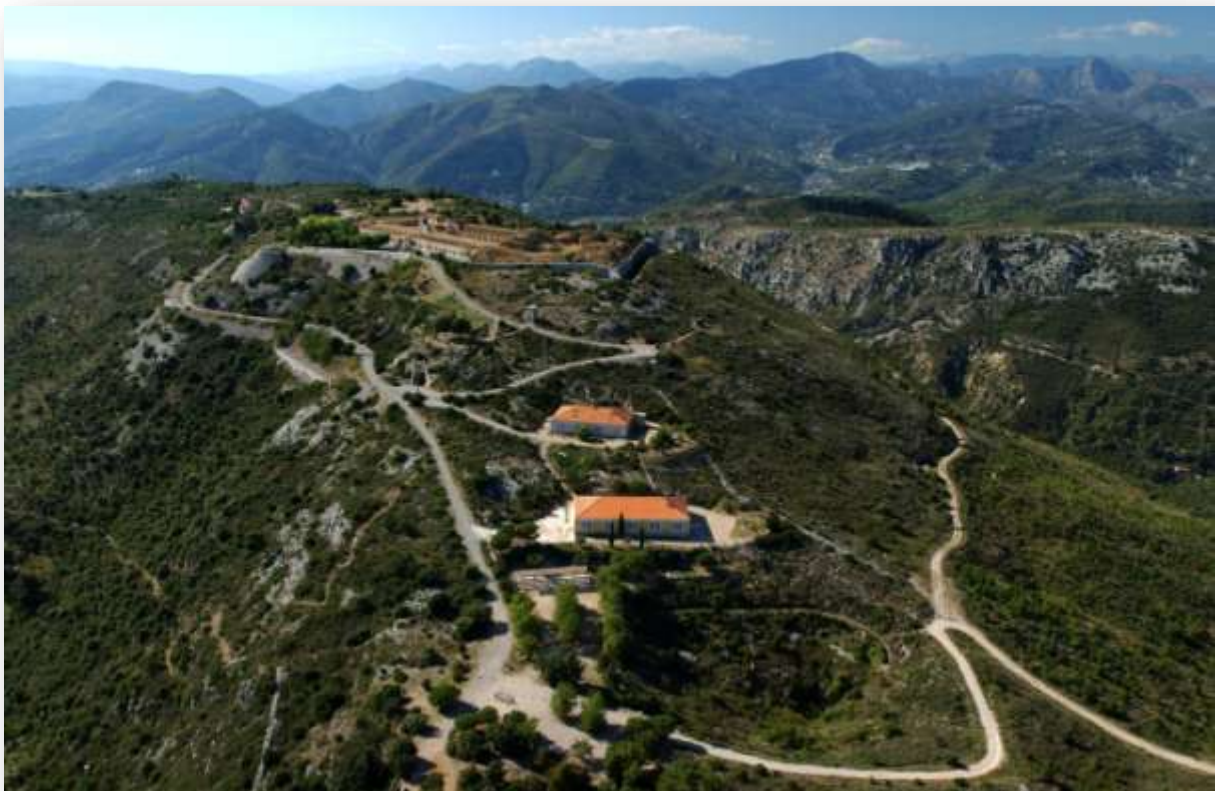
Vue aérienne du Fort de la Revère (© Y. Strebler - CG 06)
