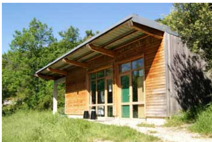
La bâtiment de l'infirmerie © Mathieu ARAGNOUET / LPO PACA
