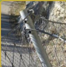
Poteaux des filets anti-éboulement<sup>2</sup>
