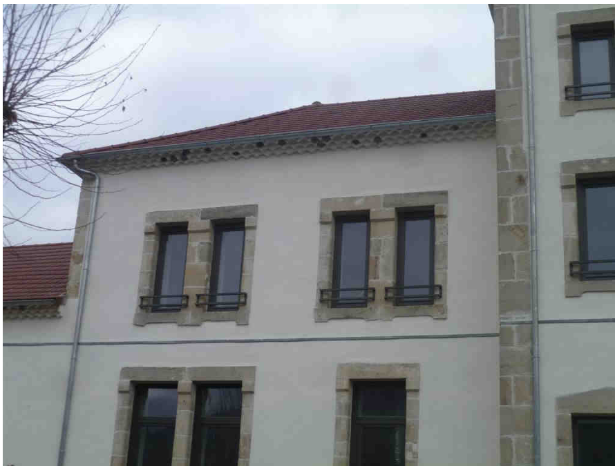
Nids sous génoises préservés malgré les travaux de rénovation du toit et de la façade (mairie de Vesseaux)
