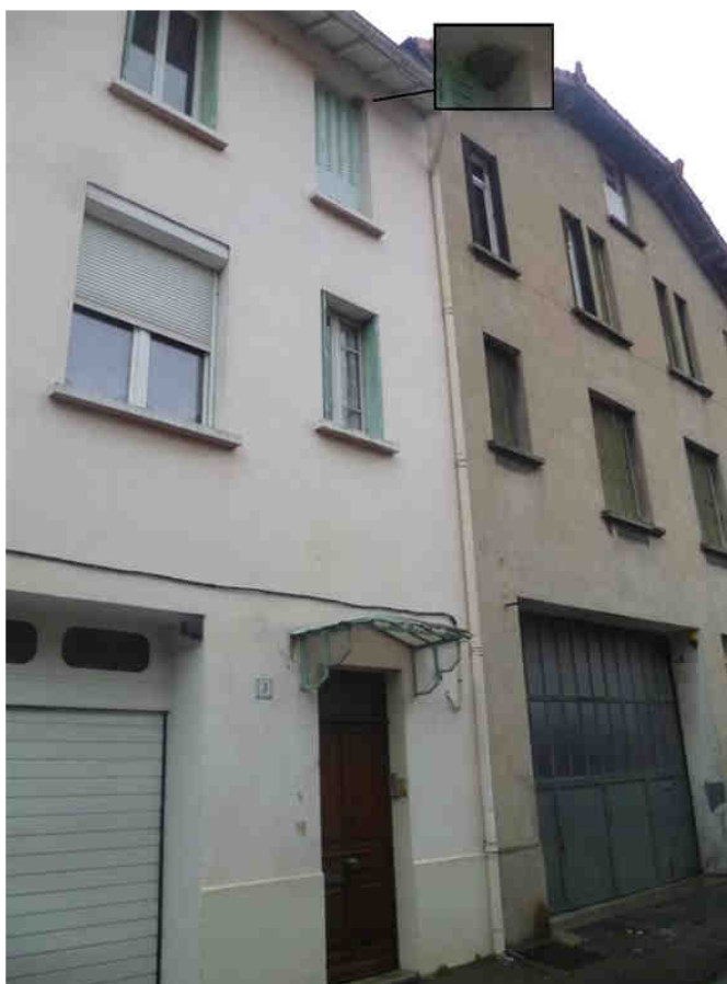
Nid dans l'encadrement d'une fenêtre bloquant l'ouverture du volet - Le Teil
