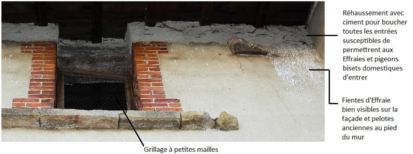
Figure 1 : Clocher de Crans après réaménagement et pose d'un Grillage ayant provoqué intentionnellement le
