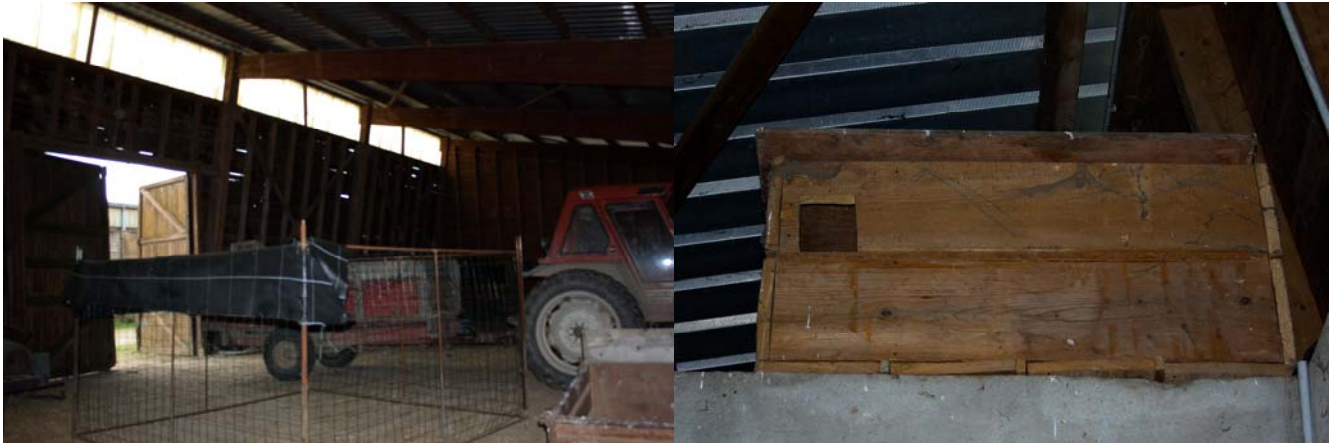
Figure 15 : à gauche : bâtiment de Grange Neuve abritant de Effraies des clochers et à droite, un nichoir à Effraie des clochers inutilisé, posé par le Parc des oiseaux dans cette grange.
