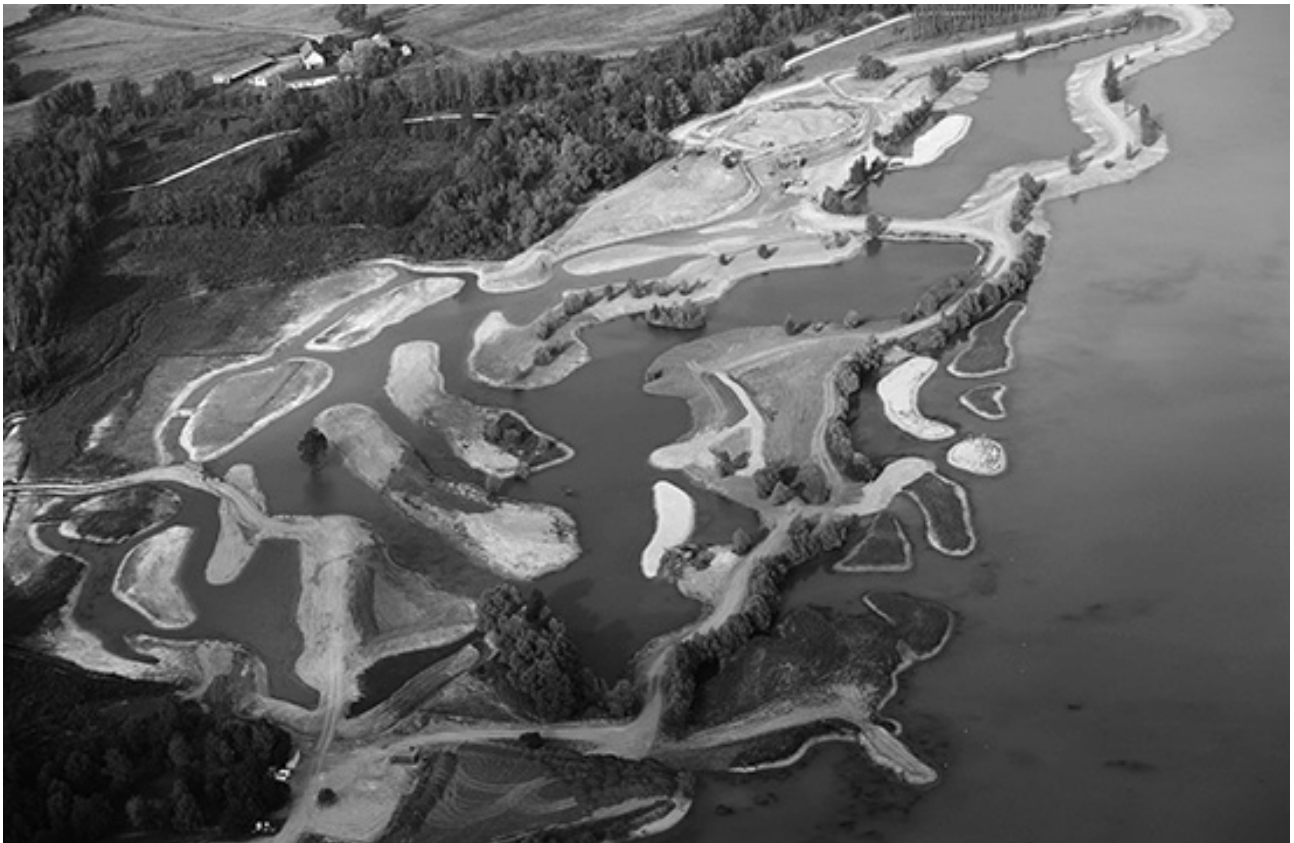
Photographie 2 : Photographie aérienne des aménagements (photo : entreprise Bellin)
