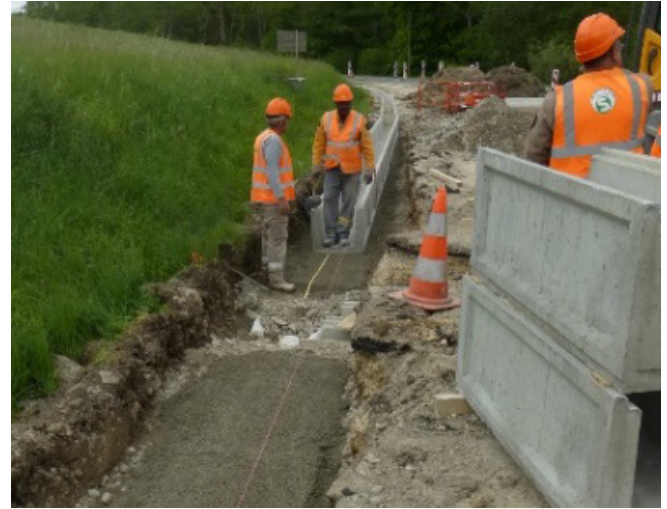
▲ Construction du passage à faune au printemps 2015, terminé en novembre 2015. © Baptiste Doutau
