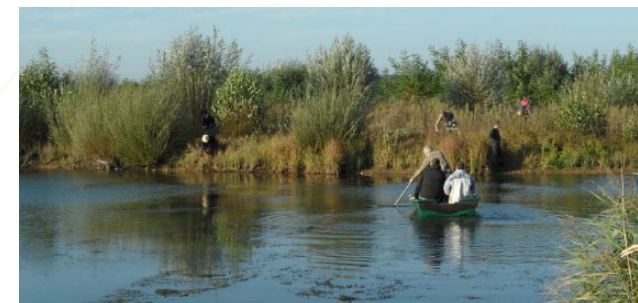
Chantier de réouverture à Pagney (39) © Cyrielle Bannwarth
