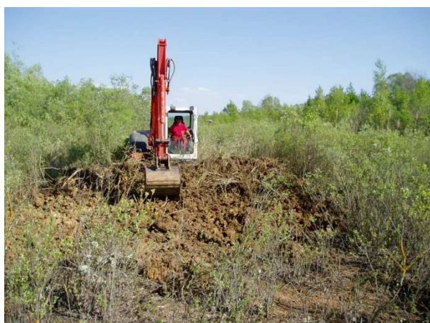
Figure 11 : décapage à la pelle mécanique
