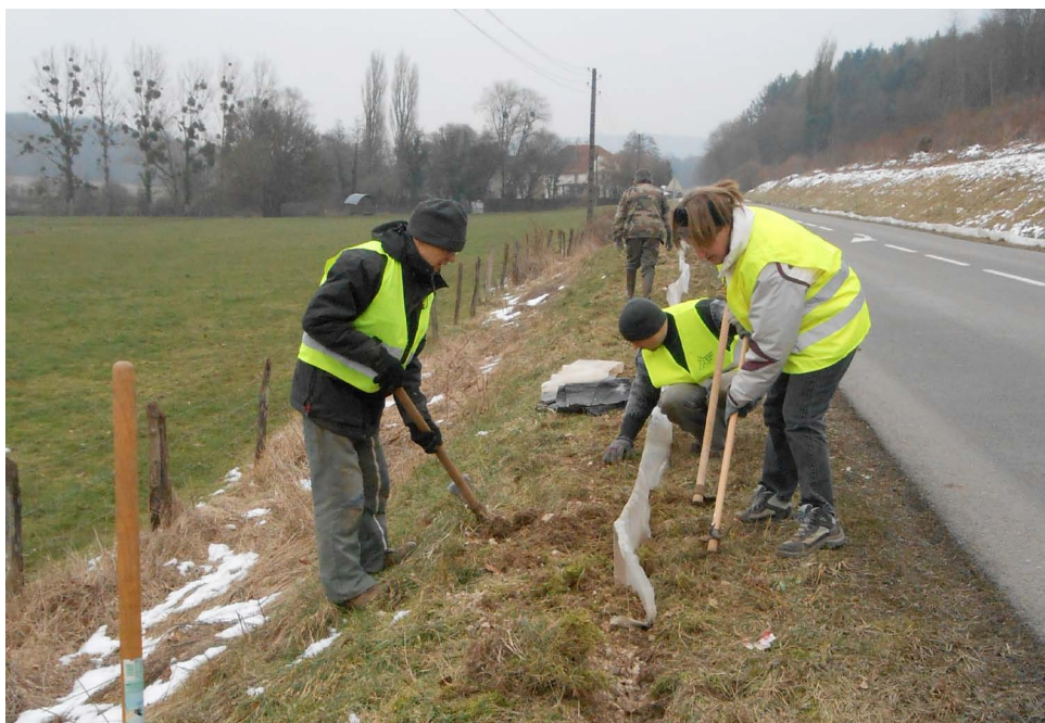
Ecolocataires pour l'installation du dispositif de protection © Nathalie Dewynter
