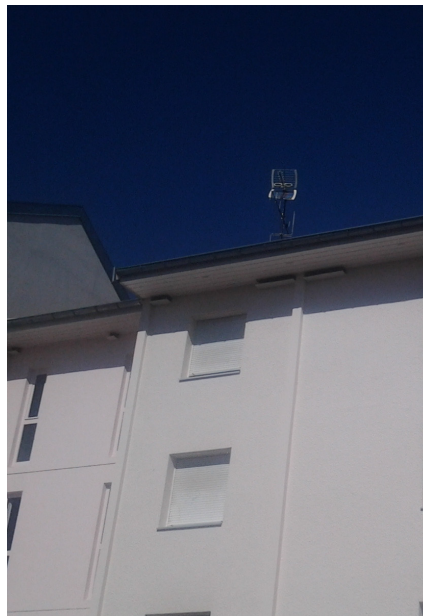
Bâtiment réhabilité, intégrant les hirondelles © Habitat 25
